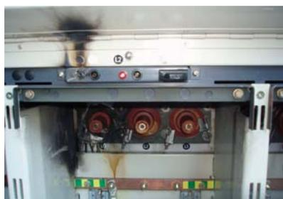
**Bild 6.2: Schädigung eines unzureichend abgesteuerten kapazitiven Teilers durch Erdschluss**
