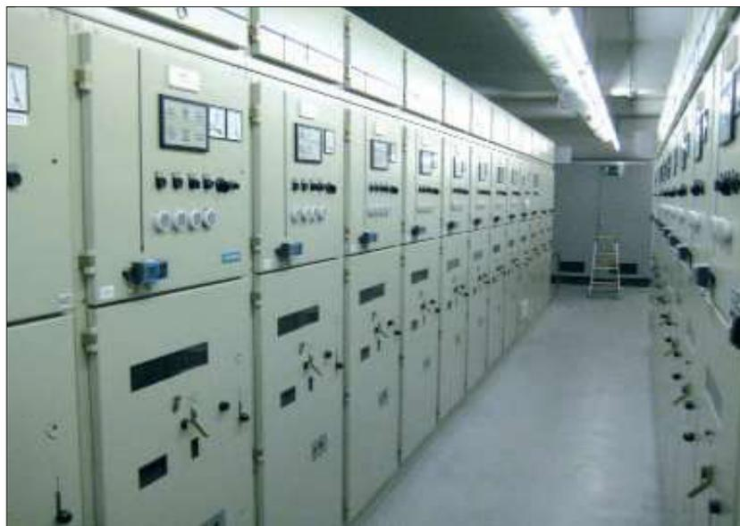
*Bild 2: Als Betreiber des Großflughafens verfügt Fraport über ein eigenes Mittelspannungsverteilstromnetz mit vier Umspannwerken und mehr als 500 Transformatorstationen in etwa 170 Schaltanlagen.*
