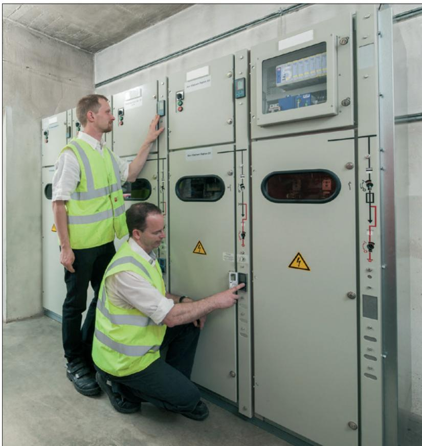
**Bild 4:** Die Stadtwerke Ratingen haben relativ früh begonnen, intelligente Netzstationen zu bauen, um einen Ausbau des Kabelnetzes zu verhindern bzw. zu verzögern. Zu den wichtigen Komponenten bei der Netzüberwachung gehört auch der Grid-Inspector IKI-50 der Kries-Energietechnik.
