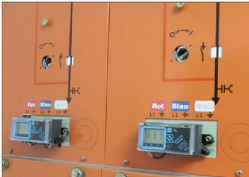
Bild 3: Nachrüstbares wartungsfreies Spannungsprüfsystem CAPDIS-PI-RR4 zur Umrüstung von HR-Schnittstellen
