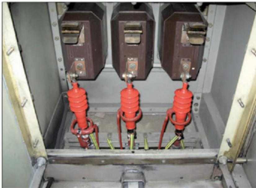
**Bild 4: Nachrüstbarer Umbau-Spannungssensor für luftisolierte Kabelendverschlüsse und Nachrüstung von CAPDIS**
