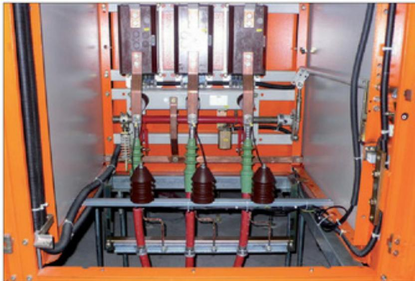
Bild 2: Eingebaute kapazitive Koppel­elektroden für Nachrüstung von CAPDIS in luftisolierten Anlagen
