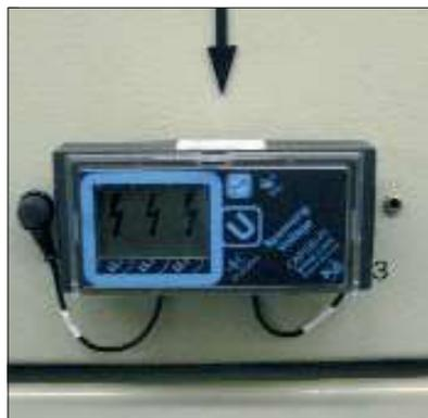
*Bild 1: Die Umstellung auf Span-nungsprüfsysteme Capdis-PI von Kries-Energietechnik spart der Fraport AG teure sowie zeit- und personal-intensive Wiederholungsprüfungen.*
