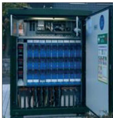
*Bild 2: In der Niederspannungsnische sind die Komponenten zur Fernwirkankopplung untergebracht.*
