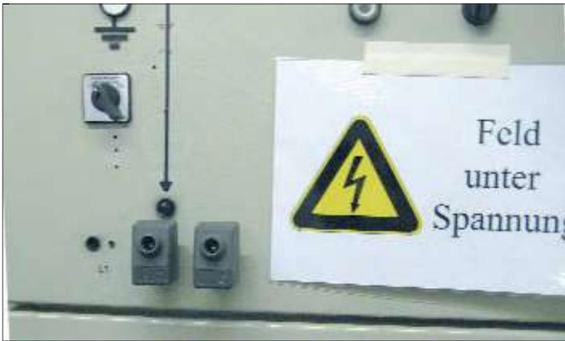
Bild 5: Früher wurden SF<sub>6</sub>-isolierte Schaltanlagen eingesetzt, die teilweise mit steckbaren, kapazitiven hochohmigen Spannungsprüfsystemen versehen waren.
